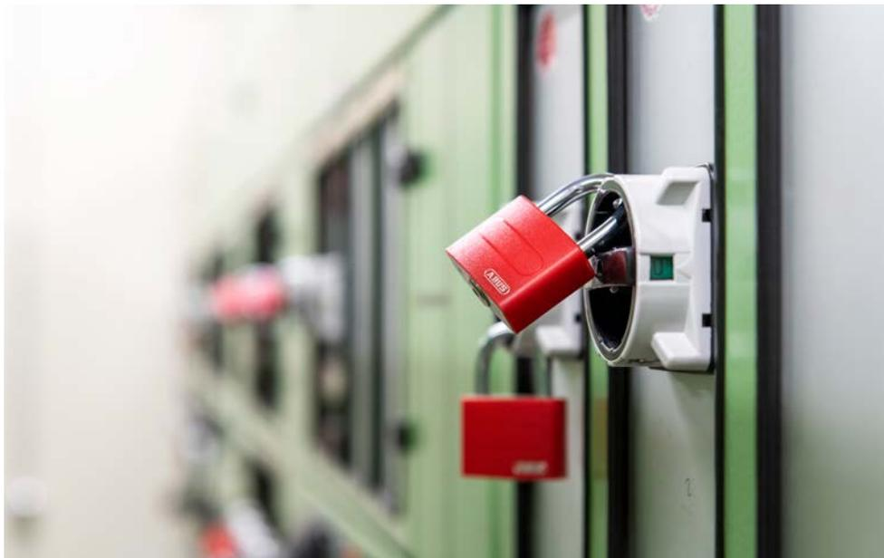
*Während der Revision eines Kessels sind elektrische Aggregate mit Schlössern gegen versehentliches Einschalten gesichert.*
