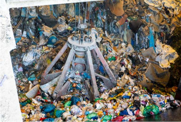
*Blick in den Müllbunker. Der Greifer nimmt den Müll auf, um ihn im Bunker zu mischen oder in den Trichter eines Kessels zu geben.*
