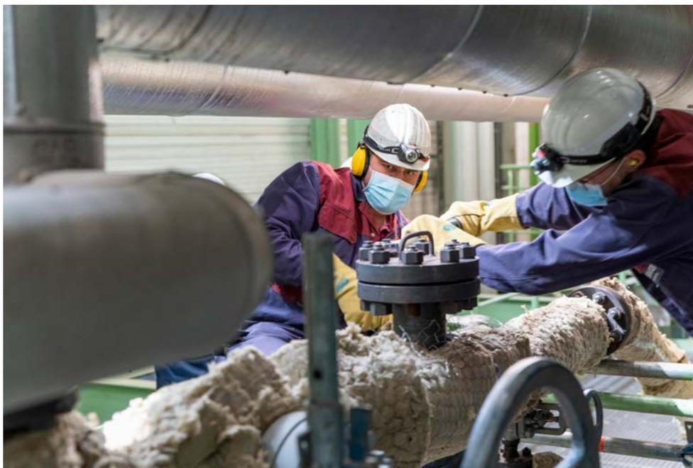
*Am Ende der Revision muss sichergestellt werden, dass sich keine noch so kleinen Partikel in der Heißdampfleitung befinden, die die angeschlossene Turbine beschädigen könnten. S. Möbius (l) und S. Weimbs (r) verschließen eine Inspektionsstelle.*
