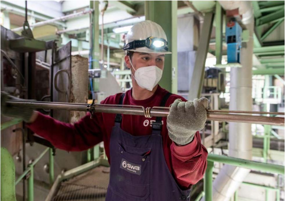
*Ü. Gürsoy, Mitarbeiter im Emissionscontrolling, kontrolliert im Zuge der Revision eine Messsonde, die den Sauerstoffgehalt im Rauchgasstrom misst, auf Beschädigungen.*
